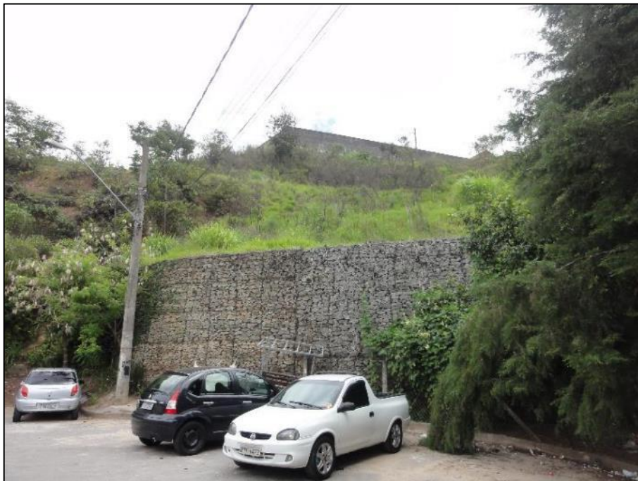
Figura 65 – Vista do muro de contenção de gabião no final da rua Sebastião de Oliveira Queiroz.
