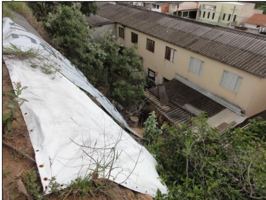
Figura 69 – Ponto com processo erosivo no talude recoberto por lona.
