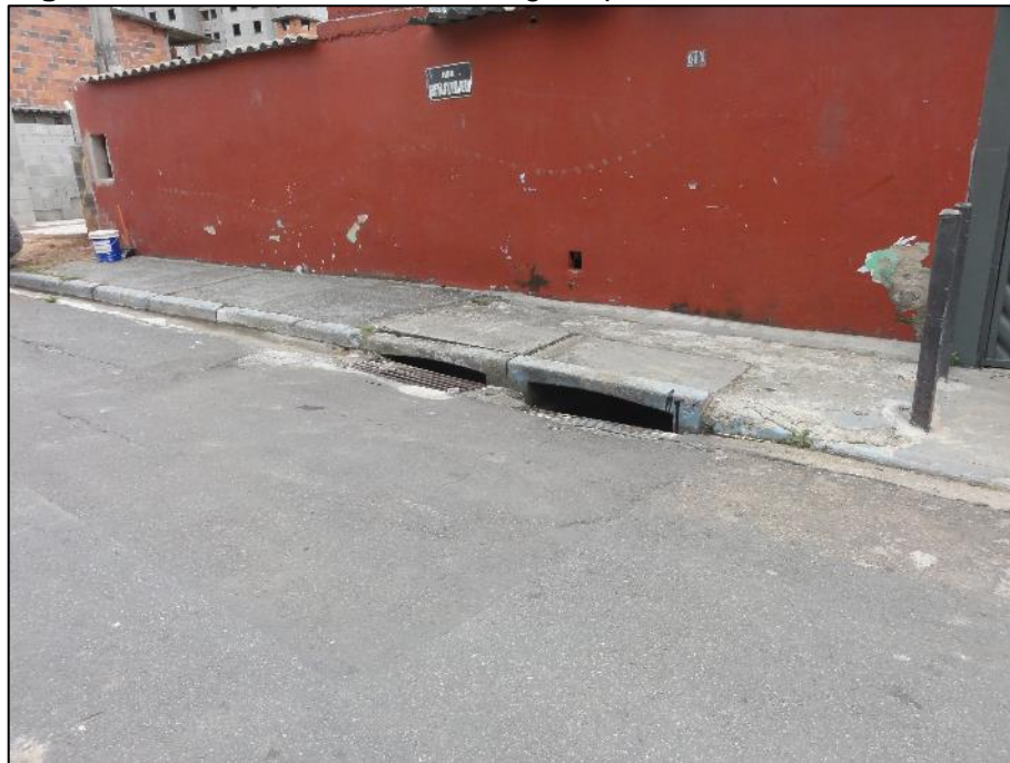
Figura 21 – Sistema de coleta de águas pluviais. Boca de lobo.
