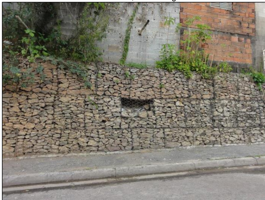
Figura 68 – Notar no muro de contenção de gabião, localizado na rua Sebastião Queiroz de Oliveira, uma das gaiolas danificadas.
