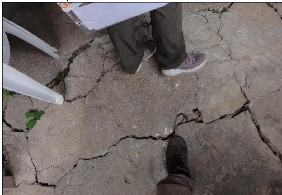
Figura 73 – Detalhe do piso da área de serviço de uma moradia localizada no topo do talude de aterro.
