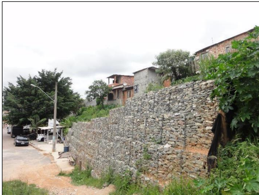
Figura 66 – Vista do muro de contenção de gabião no final da rua Bom Sucesso.
