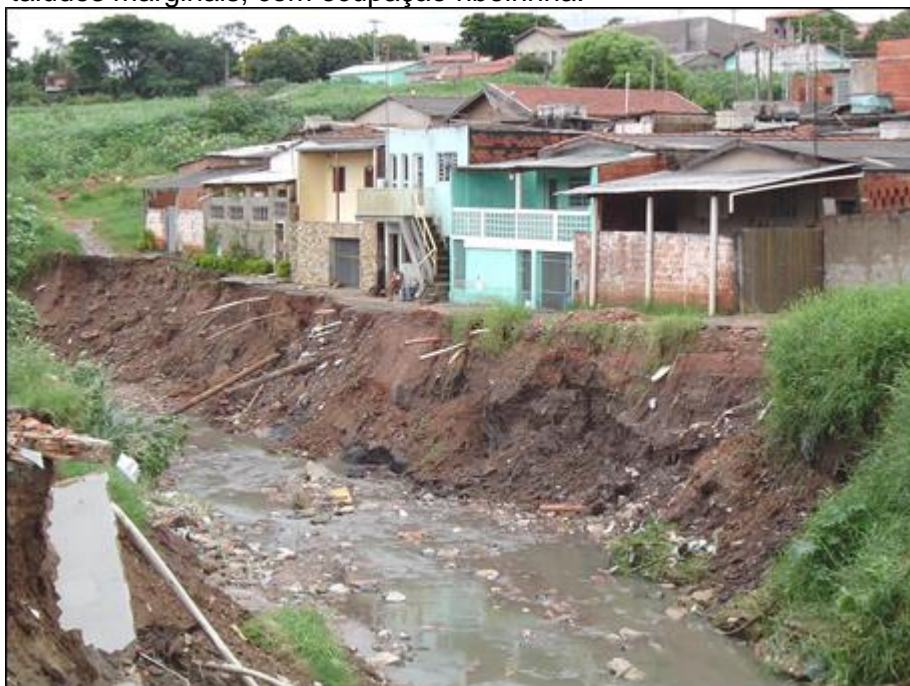
Figura 6 – Situação de risco associada a erosão e solapamento dos taludes marginais, com ocupação ribeirinha.
