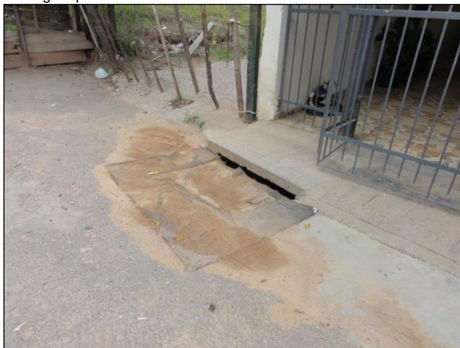
Figura 72 – Detalhe do material carreado para o sistema de drenagem pluvial.
