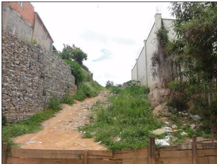
Figura 71 – Acesso com deficiência no sistema de drenagem e com lixo e entulho.
