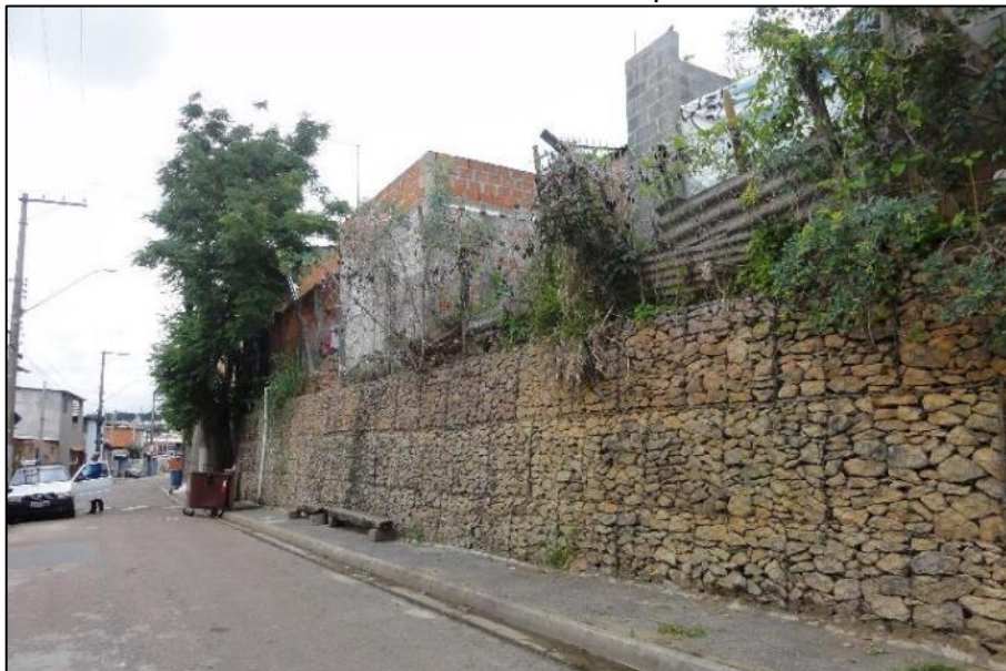
Figura 64 – Vista do muro de contenção de gabião na rua Sebastião de Oliveira Queiroz. Notar as moradias no topo do muro.
