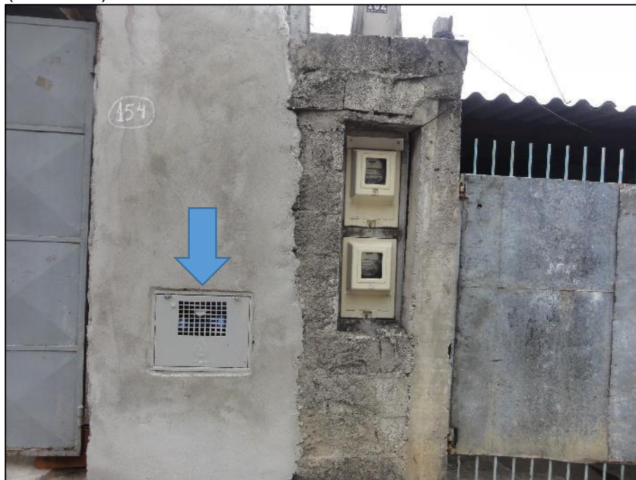
Figura 15 – Abastecimento de água. Hidrômetro instalado pelo DAE (Seta Azul).
