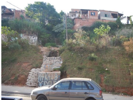
Figura 9. Ocupação em cabeceira de drenagem (SP_JUNDIAI_SR_5_CPRM)
