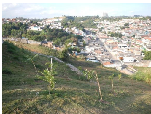
Figura 19. Muro de gabião e área de risco recuperada
