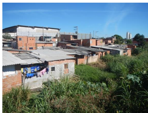
Figura 12. Residências implantadas às margens de um afluente do Rio Jundiaí, em sua planície de inundação (SP_JUNDIAI_SR_20_CPRM)
