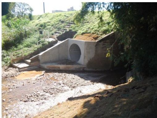
Figura 23. Construção de tunnel liner para ampliação da vazão do Córrego da Valquíria sob a Rodovia Anhanguera
