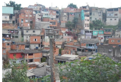
Figura 8. Densa ocupação irregular em encosta natural, gerando cortes e aterros, com casas geminadas (SP_JUNDIAI_SR_6_CPRM)
