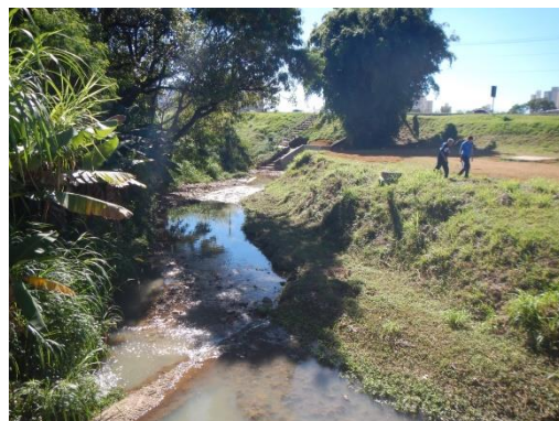
Figura 24. Retaludamento da margem do córrego e desassoreamento do leito do curso d'água
