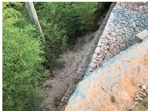
Figura 22. Encosta muito íngreme recuperada e construção de muro de gabião
