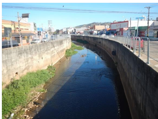
Figura 11. Rio Guapeva canalizado na região central do município de Jundiaí, onde ruas, avenidas e construções ocupam sua planície de inundação (SP_JUNDIAI_SR_23_CPRM)
