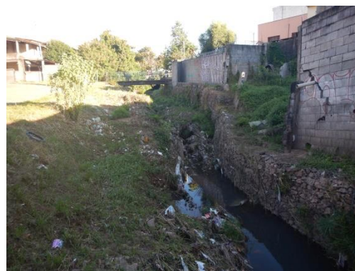
Figura 16. Grande quantidade de lixo e entulho lançados no Córrego Tanque Velho (SP_JUNDIAI_SR_27_CPRM)
